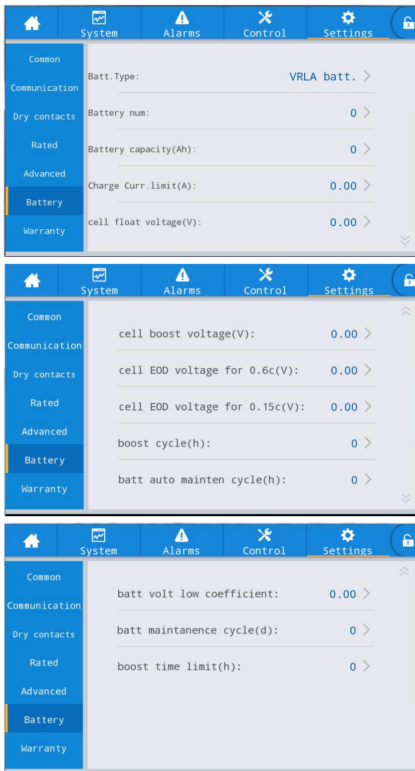
Fig. 4-19 Battery parameters interface
